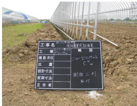
写真の様にビニペットの通りが直線であれば、巻き上げのフィルムなどの狂いも少なく、巻き上げの際にも均等に上がります。
