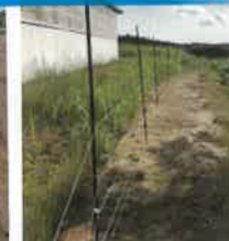
●畜舎の周囲を囲む 電気柵設置例
