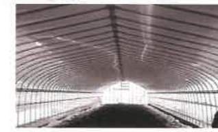
湯沢地区平成30年12月 4×25Kハウス 耐雪強度試験 直管 曲がり管 STX780仕様。 屋根上部へ積雪約2M。
